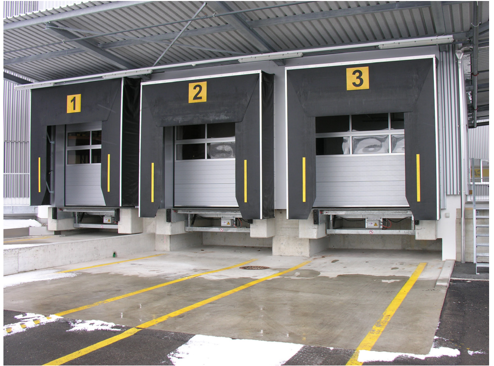
Abb. 5 Moderner Güterumschlagplatz mit Andockkrampen
